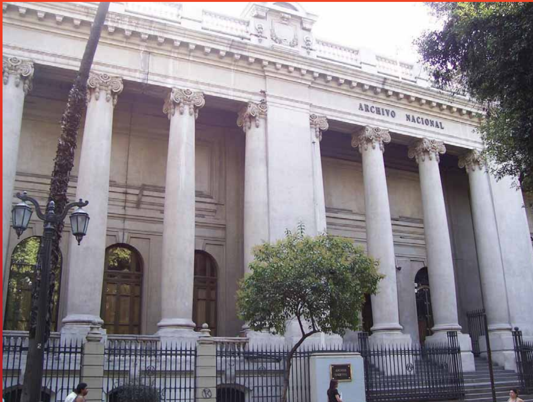
Fachada del edificio sede del Archivo Nacional Histórico
