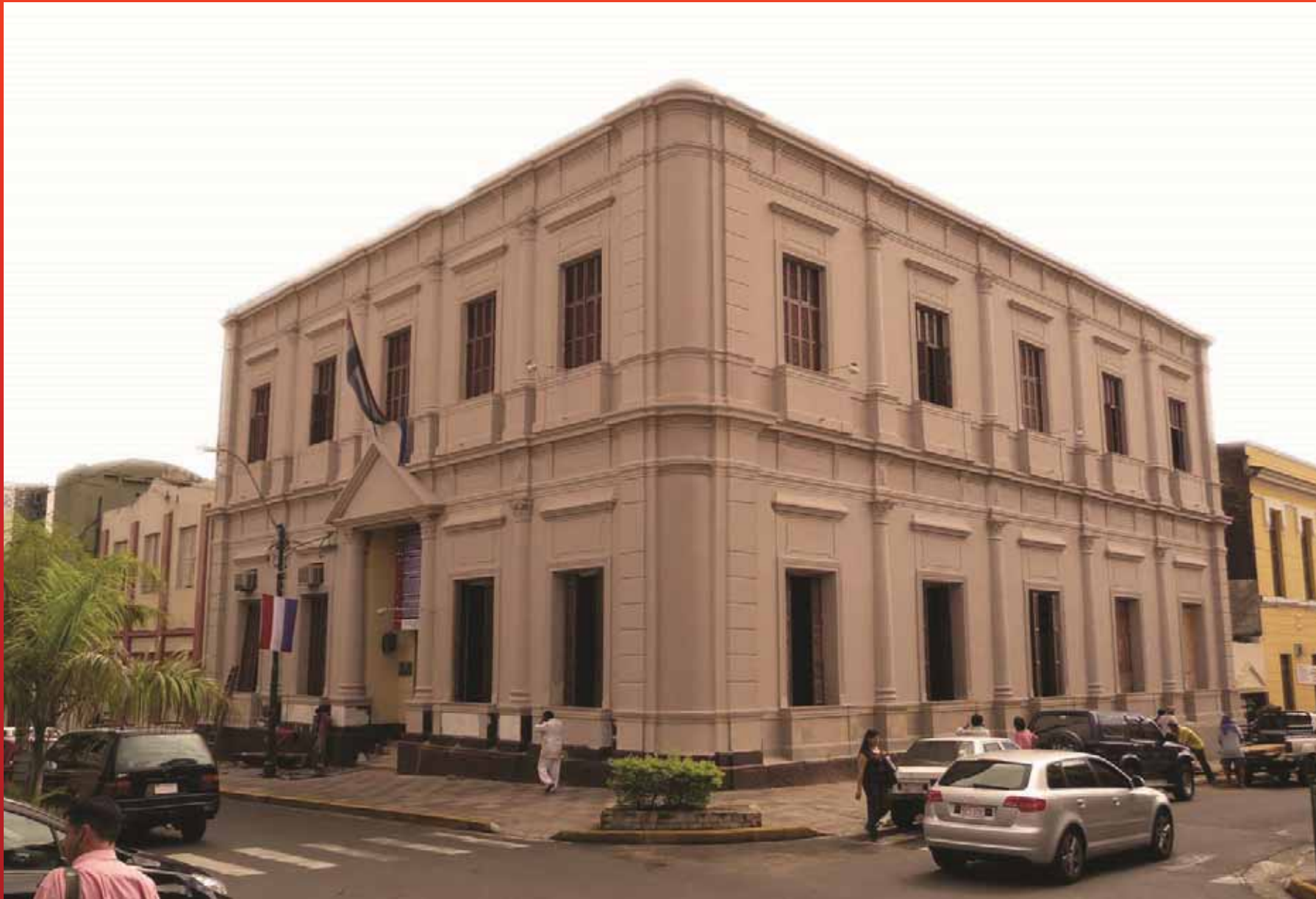
Fachada del Edificio del Archivo Nacional de Asunción – ANA
